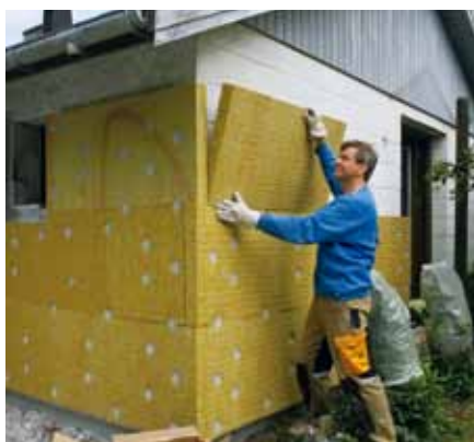
Hullet til sømdivvlen bores med et 8 mm bor, der når 13 cm ind bag overfladen.
