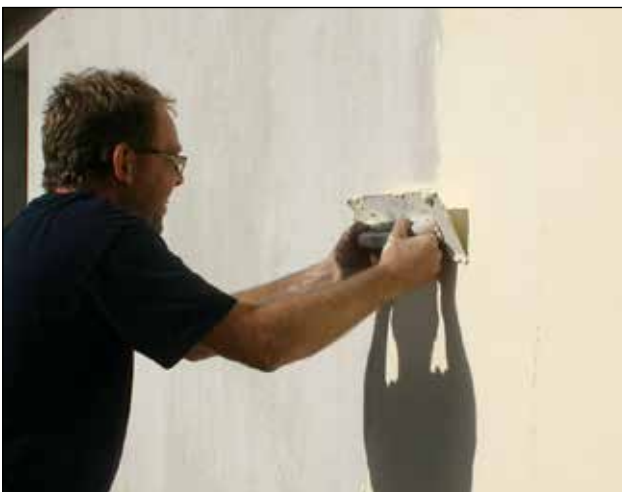
21. Skalcem S2000/CF2000 trækkes på facaden.
