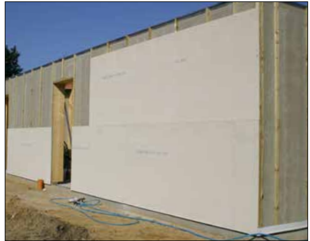
8. Bluclad-pladerne monteres i forbandt på hele facaden.
