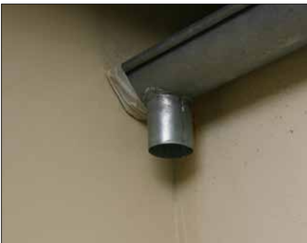
23. Det er en god idé at afdække f.eks. tagrender med malertape, inden der slutpudses.
