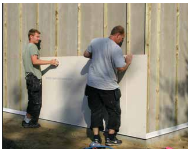
6. Bluclad-pladerne monteres. En murersnor markerer Bluclad-pladernes overkant.
