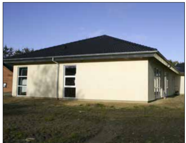
24. Facaden er færdigpudset. Som alternativ til Skalcem S2000/CF2000 kan Skalcem 3000 eller Skalflex Silikonepuds anvendes.
