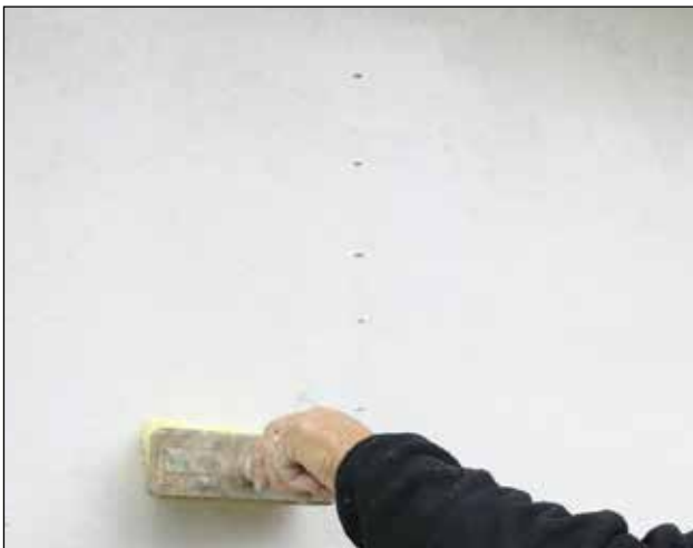
9. Hele facaden grundes med Skalflex Beto-Binder fortyndet med vand i forholdet 1:3.
