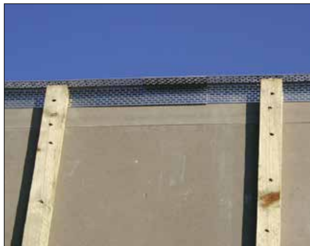
2. Udluftningsprofilen skal overlappe ved samlinger.
