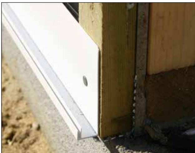
3. Udluftningsprofil og kantprofil er korrekt monteret.
