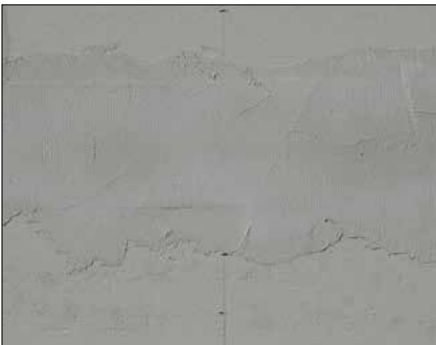
11. Pladesamlinger forstærkes med en netstrimmel, som arbejdes ind i Multiklæb®.
