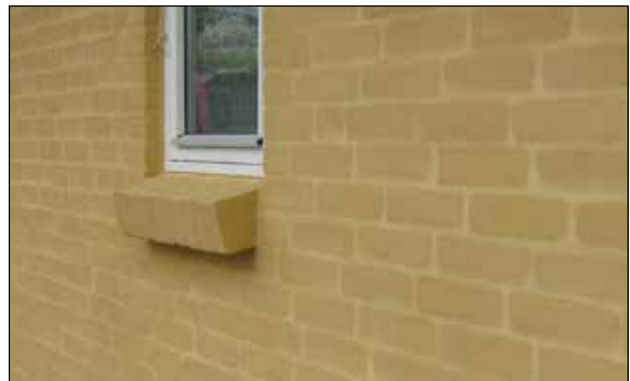
Eksempel på Murstensmønster/vandskuring
