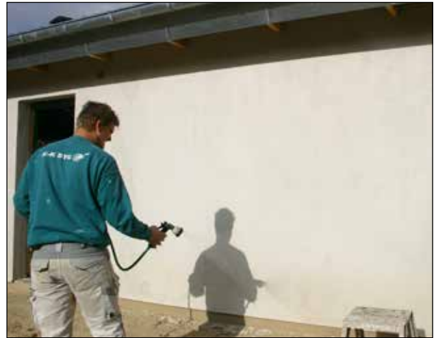
20. Efter ophærdning forvandes facaden.
