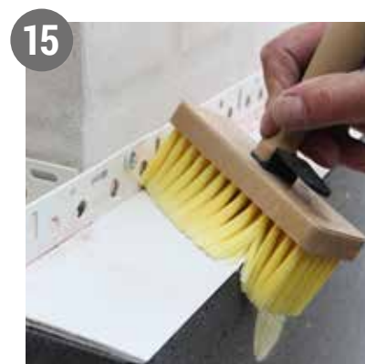
Borestøv fjernes fra profilen.
