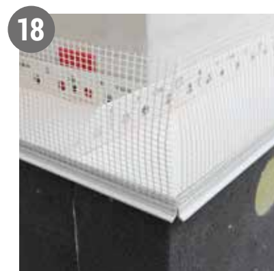
Sokkelindstikkene skubbes på plads, så hjørnet bliver helt samlet. Ved samlinger skal sokkelindstikket forskydes min. 10 cm i forhold til sokkelprofilen.
