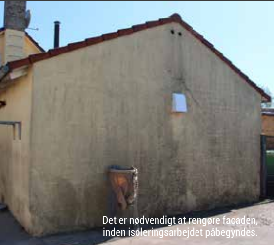
Beskadiget puds og maling skal fjernes, så isoleringsløsningen opnår størst mulig vedhæftning.
