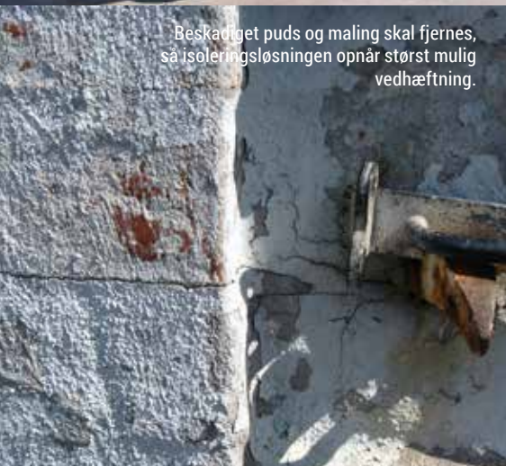
Facaden oprettes, hvis den ikke er plan og stokret.
