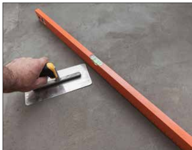
2. REPARATION: Der udfyldes/repareres med Skalflex Grovbeton. Glat overfladen med spandeske, stålbræt eller lign.
