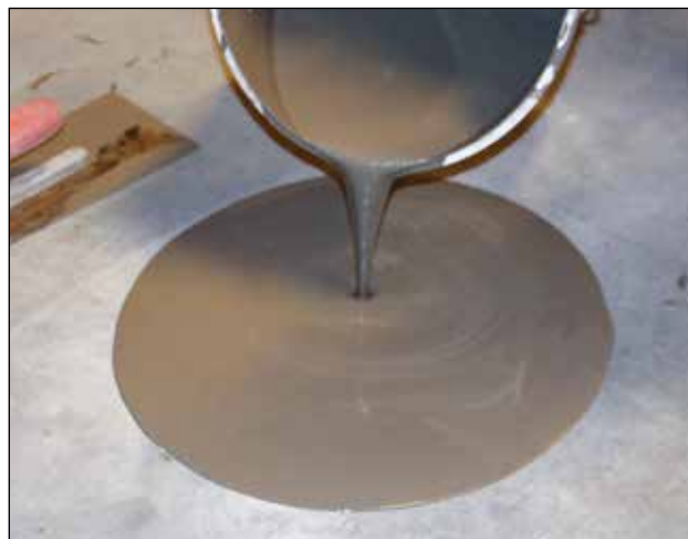
2. Skalflex Gulvspartel hældes ud på gulvet.
