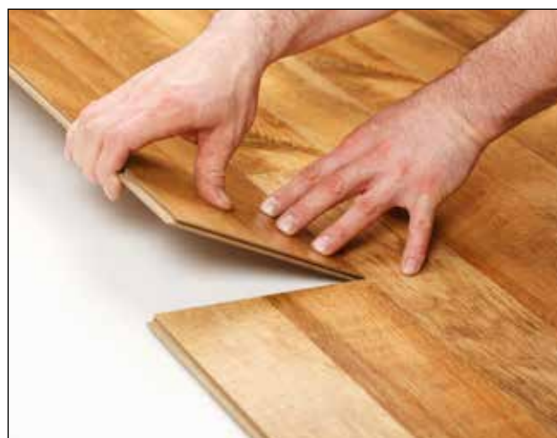
5. Efter afbinding skal gulvet beklædes med en egnet gulvbelægning (tæpper, fliser, linoleum, trægulve m.m.)
