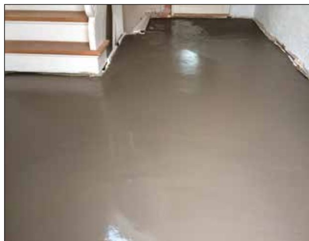
4. Gulvspartlen er gangbar efter 1-3 timer.
