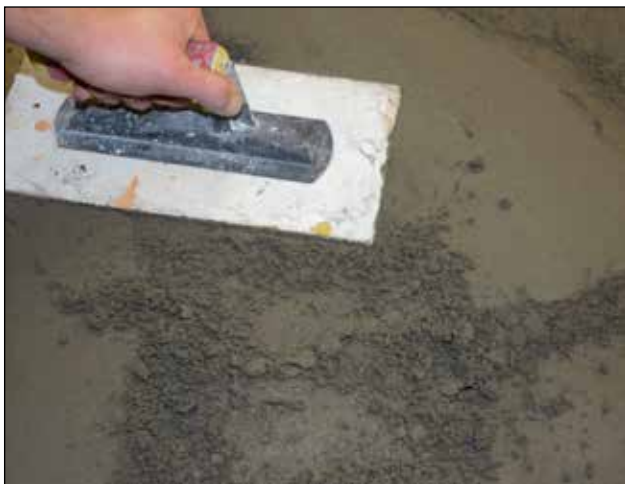
3. Umiddelbart efter færdiggøres reparationen med påføring af beton. Det er vigtigt, at der arbejdes vådt-i-vådt med hæftesvummen.
