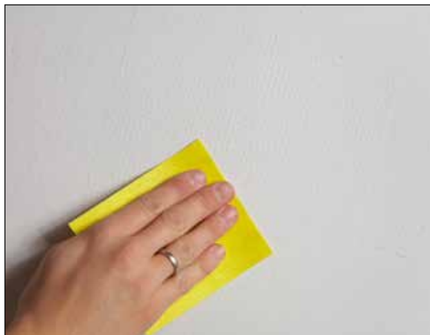
Ujævnheder og grater kan slibes væk med finkornet sandpapir (korn 150-200).
