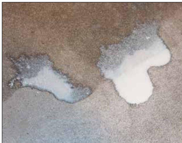
Der må ikke forekomme primersøer, når der skal arbejdes videre på primet underlag.
