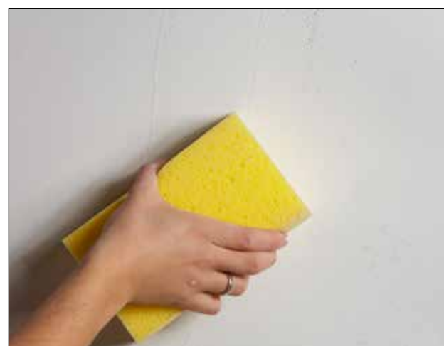
3. Bearbejd evt. overfladen med tør svamp. Ujævnheder og grater kan slibes væk med finkornet sandpapir (korn 150-200) inden for 7 døgn.
