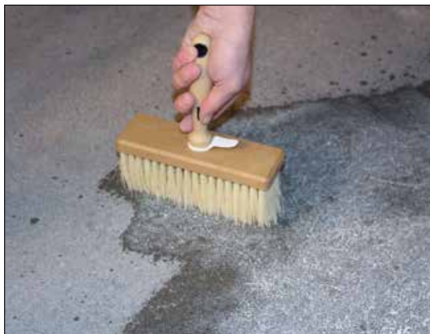
1. Gulvet grundes med Skalflex Gulvprimer (se side 9).
