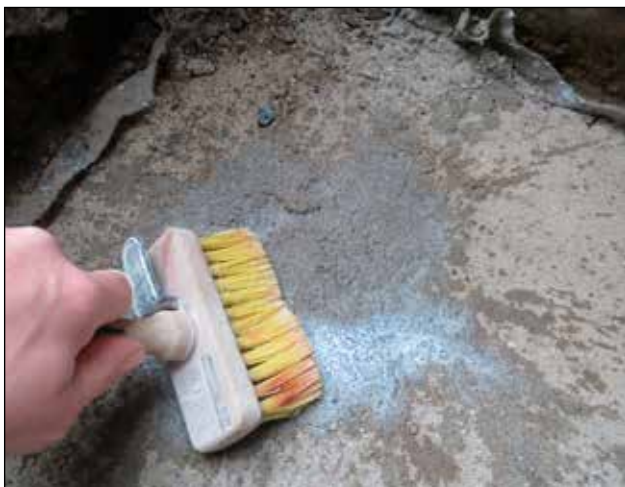
1. Reparationsstedet forvandes, svømmes eller primes med Skalflex Gulvprimer eller Skalflex Beto-Binder (se side 8-9).
