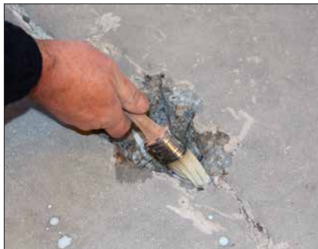
2. Reparationsstedet primes med Skalfles Gulvprimer opblandet med vand i forholdet 1:3.
