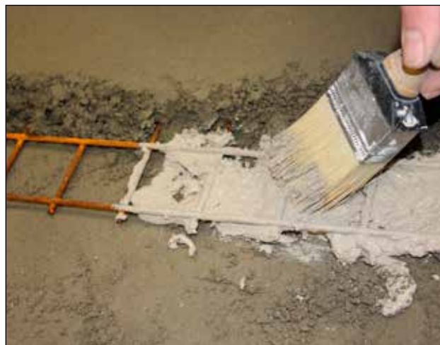
2. Skalflex Hæftesvumme påføres med pensel i en lagtykkelse på 2-3 mm. Sørg for at komme helt ud i alle hjørner og på bagsiden af armeringsstål.
