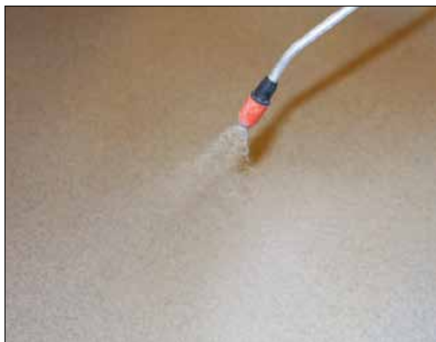
Der sprayeres med ufortyndet Skalflex Gulvprimer. Efter afbinding kan der arbejdes videre på det primede underlag.
