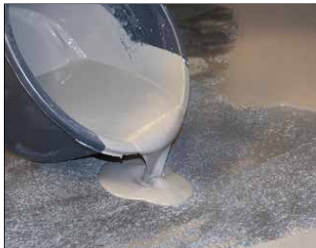
2. Skalflex Gulvspartel hældes ud på gulvet.
