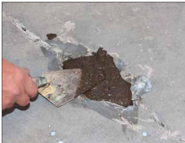
3. Opblandet Gulvmørtel Turbo fyldes i reparationstedet, og arbejdes godt ned i underlaget med spandeske, stålbræt eller lign.
