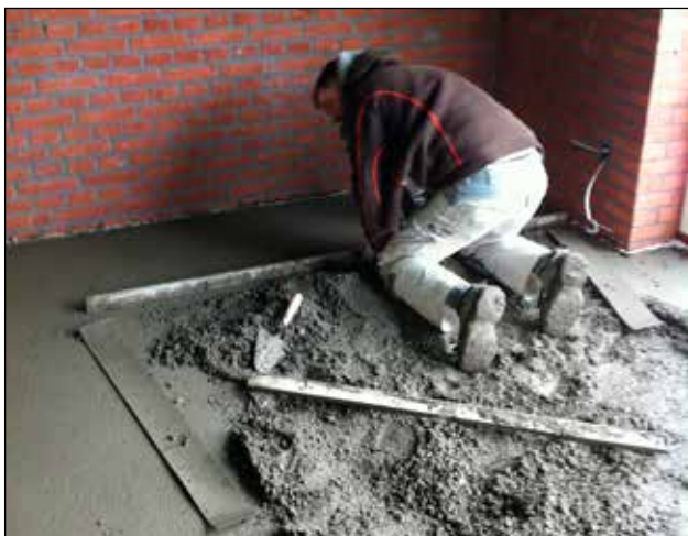
1. NYT SLIDLAG: Støbebetonen udlægges i min. 3 cm lagtykkelse. Kan udlægges på stabile underlag af polystyren, sand, grus, tætningsmembran m.m.
