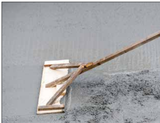
1. NYT SLIDLAG: Grovbetonen udlægges i min. 3 cm lagtykkelse. Kan udlægges på stabile underlag af polystyren, sand, grus, tætningsmembran m.m.
