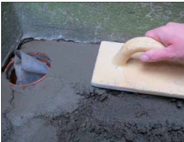
3. Når betonen har sat sig, glattes efter med pudsebræt.
