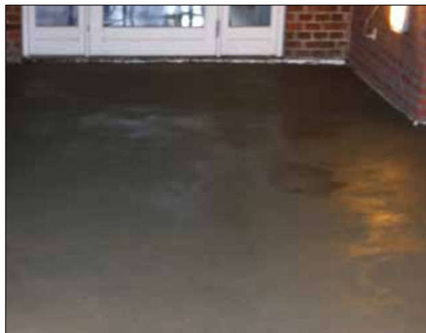
2. NYT SLIDLAG: Efter udlægning jævnes og glattes overfladen med stålbræt, pudsebræt eller andet egnet redskab.
