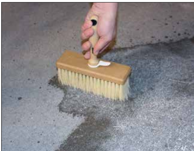
Skalflex Gulvprimer kan påføres med rulle, kost, pensel eller spray.
