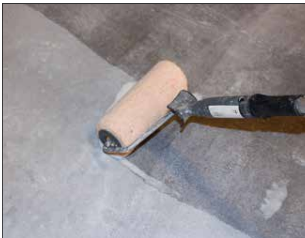
1. Gulvet grundes med Skalflex Gulvprimer (se side 9).
