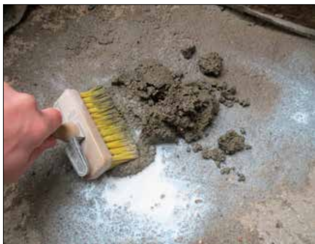
1. REPARATION: Reparationsstedet rengøres grundigt for snavs og løst materiale, og der grundes eller svummes som beskrevet på side 8-9.
