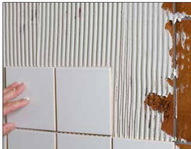
Opklæbning af fliser på fliser.
