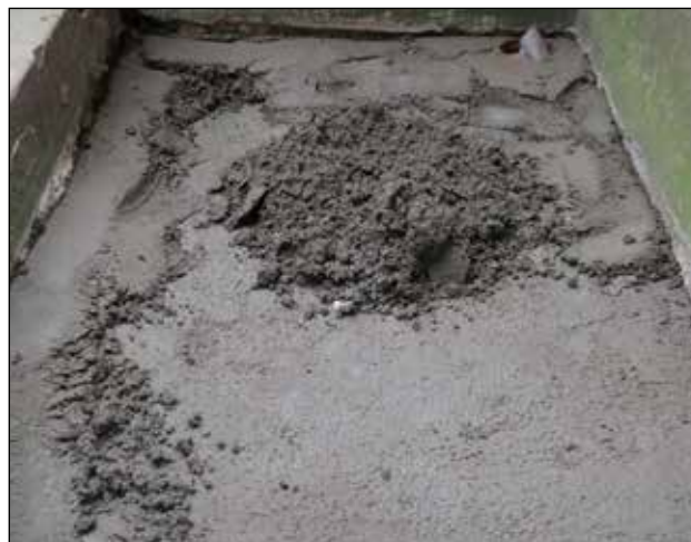
2. Den opblandede reparationsbeton påføres med spandeske eller lign. og trykkes godt på plads.
