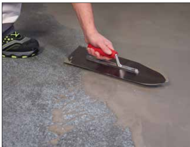
3. Gulvspartlen udlægges i ønsket lagtykkelse og fordeles med stålbræt eller pigrulle.
