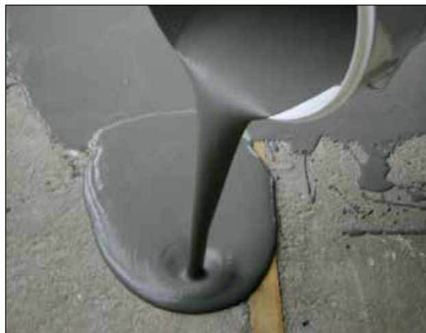
2. Skalflex Gulvspartel Grov hældes ud på gulvet og fordeles i ønsket lagtykkelse med stålbræt eller lign.
