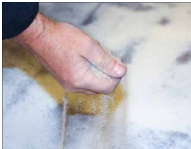
Der drysses rundhåndet med Skalflex ovntørret kvartssand 0,4-0,8 mm i den våde gulvprimer.
