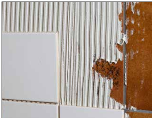
Opklæbning af fliser på fliser.
