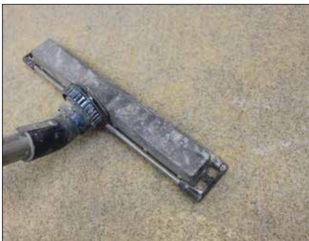
Efter afbinding støvsuges for overskydende sand.
