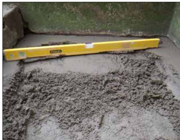
2. REPARATION: Der udfyldes/repareres med Skalflex Støbebeton. Glat overfladen med spandeske, stålbræt eller lign.
