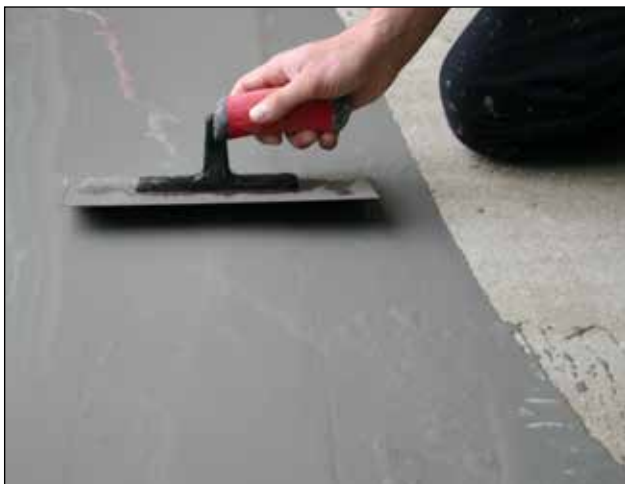
3. Til evt. fin-afretning kan der efter 1-3 døgn (afhængig af af temperatur) udlægges et lag Skalflex Gulvspartel Fin. Der skal primes forud for udlægningen.
