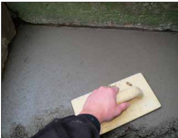
3. Når betonen har sat sig, pudses efter med pudsebræt.
