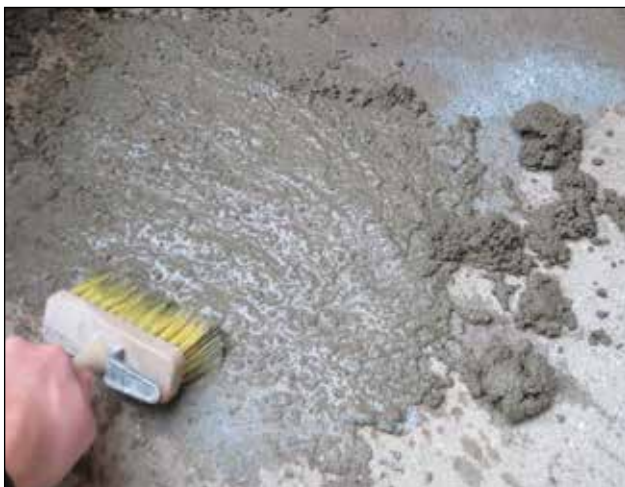
1. Reparationsstedet forvandes, svummes eller primes med Skalflex Gulvprimer eller Skalflex Beto-Binder (se side 8-9).
