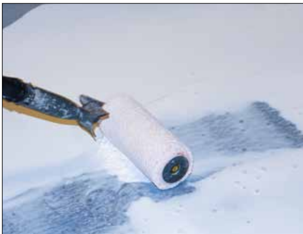
Til ekstra vedhæftningsforbedring på problematiske underlag som glat beton, klinker eller stabile trægulve fordeles rigelig mængde ufortyndet gulvprimer direkte på gulvet.
