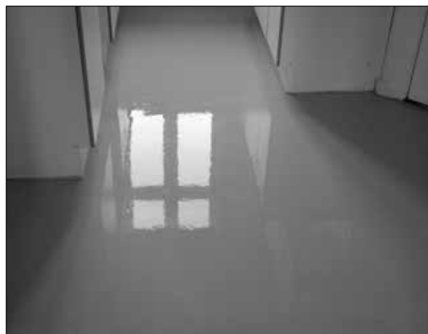
4. Gulvspartlen er gangbar efter 1-3 timer.
