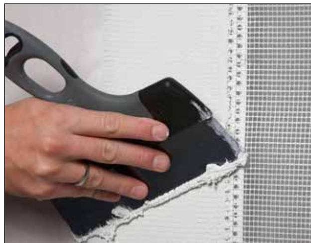
Hjørner og samlinger forstærkes med armeringsnet. Flader og samlinger ilægges Skalflex Armeringsnet. Ved hjørner anvendes Skalflex Hjørneprofil eller Multihjørneprofil.
