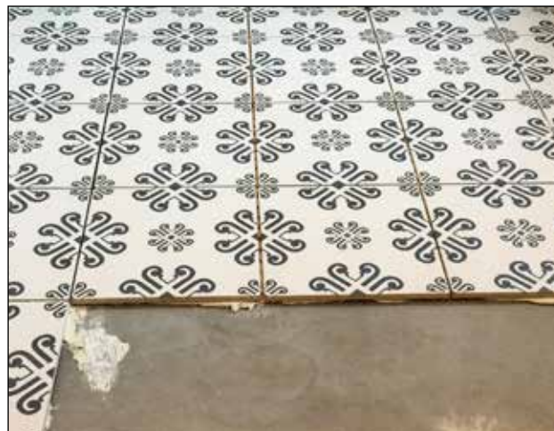
4. Efter afbinding skal gulvet beklædes med en egnet gulvbelægning (tæpper, fliser, linoleum, trægulve m.m.)
