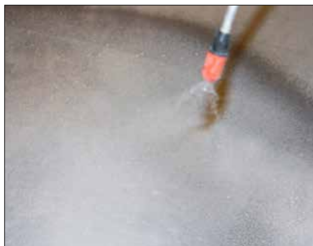
5. Efter afbinding forsegles overfladen med Skalflex Gulvforsegler eller en egnet gulvmaling. Gulvet kan også beklædes med en egnet gulvbelægning.
