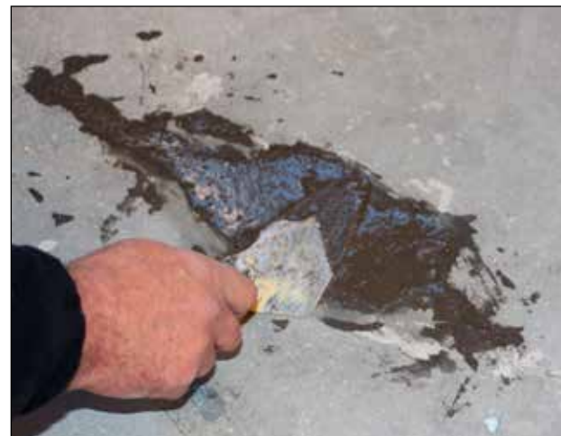
4. Overfladen glettes med spandeske eller stålbræt.
