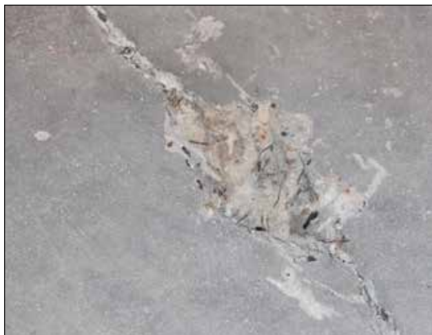
1. Reparationsstedet ruhugges til fast beton og alt løst-siddende materiale, snavs og støv fjernes.
