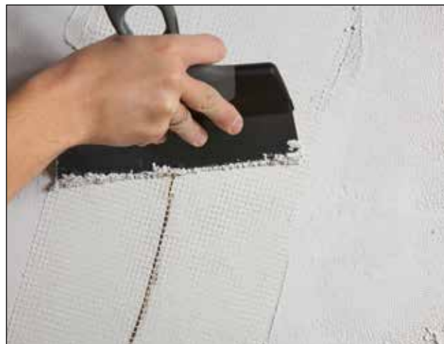
2. Nettet fastgøres med og dækkes med Skalflex Multispartel®.
