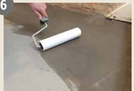
Kan efter fuld afhærdning påføres Skalflex Gulvforsægler, gulvmaling eller en anden gulvbelægning.
