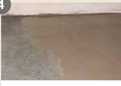
Fordel gulvpartelmassen med pigrulle, stålbræt, tandspartel eller andet egnet redskab.
