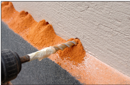
Boreddybden kan markeres med malertape.
