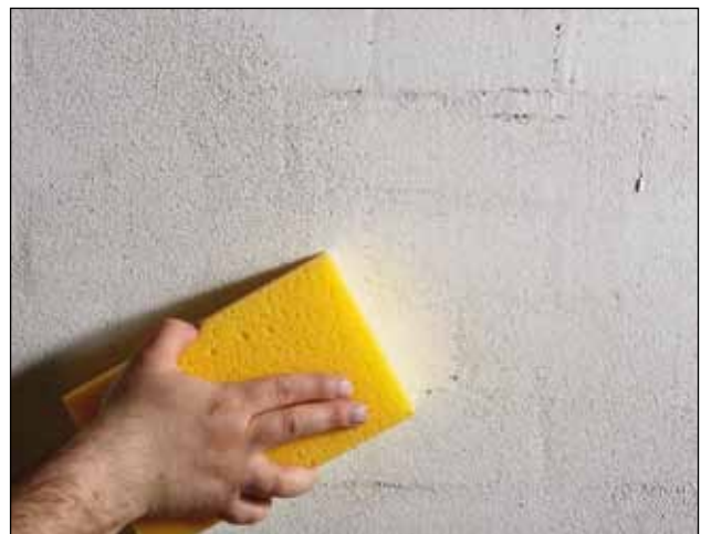
6. Vandskuringspudsen filtses med en tør eller let fugtet svamp.
