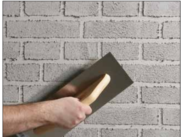
4. Når Grundpudsen er tørret op, stødes kanter og grater af med et stålbræt.
