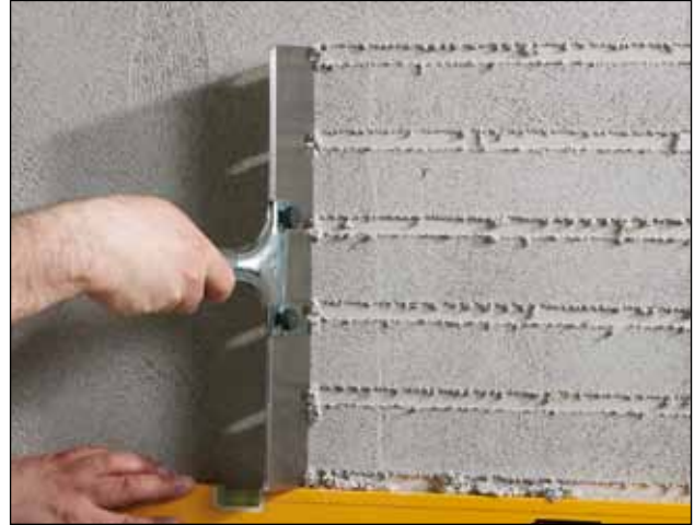
2. Ved hjælp af et vaterpas afsættes de vandrette fuger. *)
