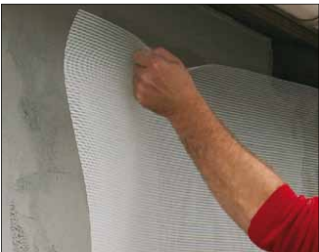
15. Skaltherm Grundpuds trækkes på med stålbræt, og nettet lægges i den våde Grundpuds.
