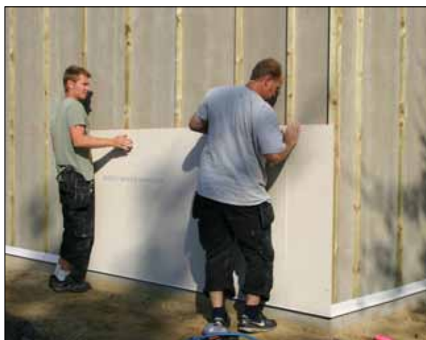
6. Bluclad-pladerne monteres. En murersnor markerer Bluclad-pladernes overkant.
