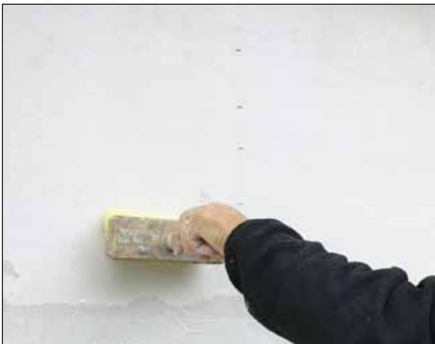
9. Hele facaden grundes med Beto-Binder fortyndet med vand i forholdet 1:3.
