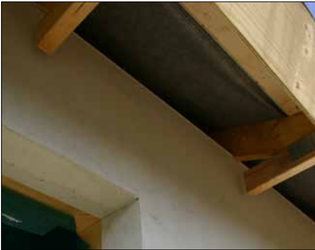
19. Bemærk, at udhænget har lidt afstand til facaden. Således er der lavet plads til pudsarbejdet.
