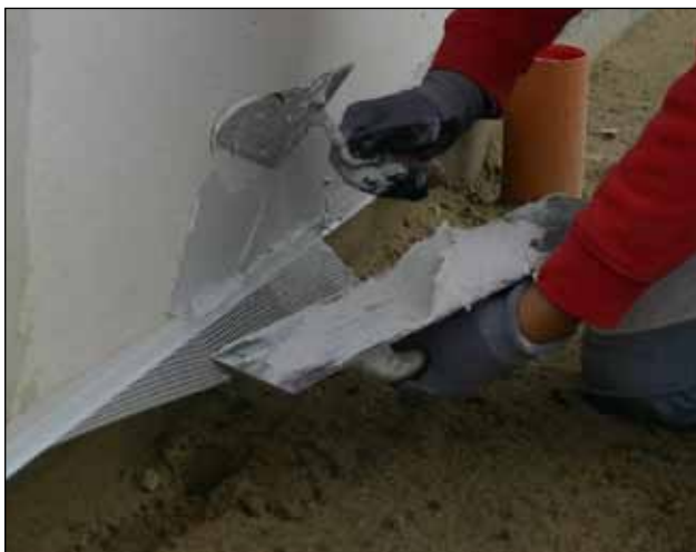
13. Ved at vippe nettet til side er det nemt at trække Multiklæb® på bag nettet.
