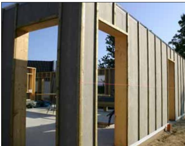
1. Der er monteret klemlister uden på vindspærren, og samtidig er udluftningsprofil og kanprofil monteret.
