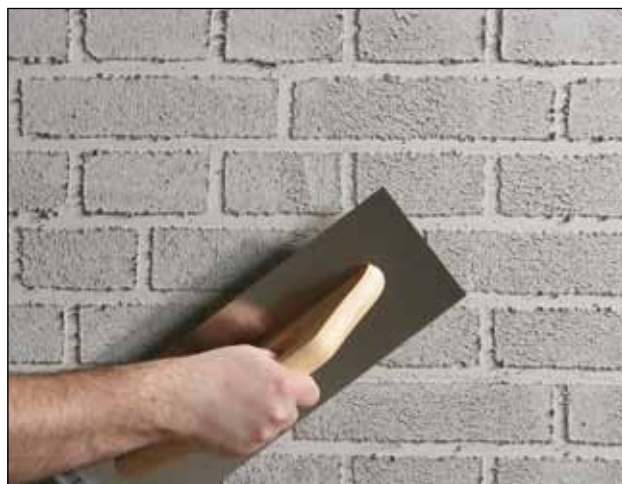
4. Når Grundpudsen er tørret op, stødes kanter og grater af med et stålbræt.
