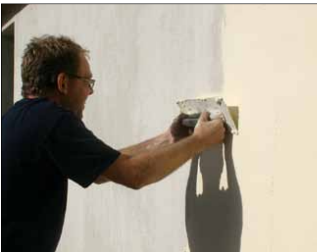
21. Skalcem S/CF2000 trækkes på facaden.
