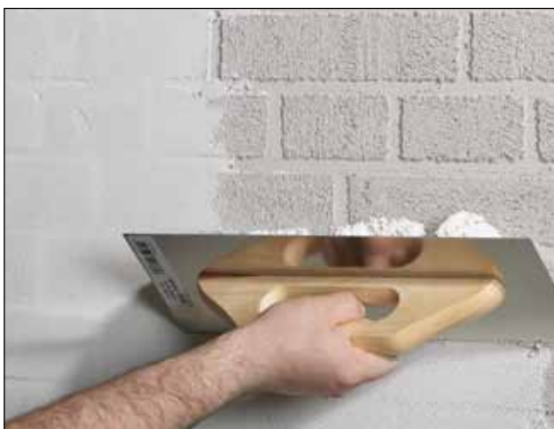
5. Efter hærkning trækkes et tyndt lag Skalflex Vandskuringspuds på overfladen.
