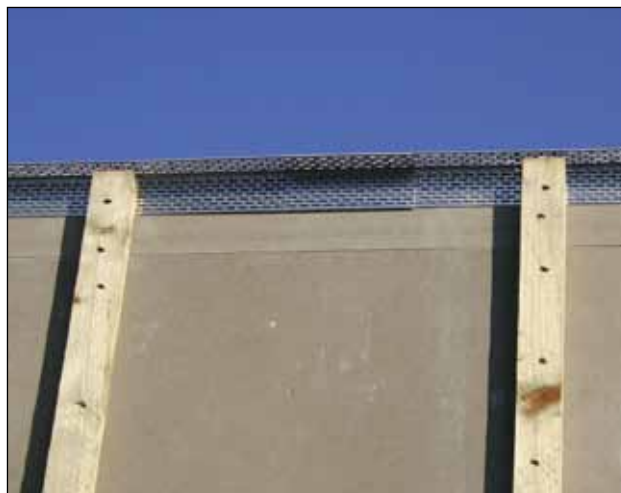
2. Udluftningsprofilen skal overlape ved samlinger.
