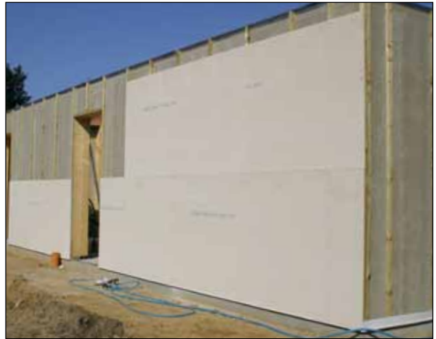
8. Bluclad-pladerne monteres i forbandt på hele facaden.
