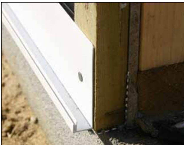
3. Udluftningsprofil og kantprofil er korrekt monteret.
