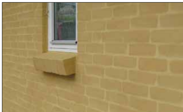
Eksempel på Murstensmønster/vandskuring
