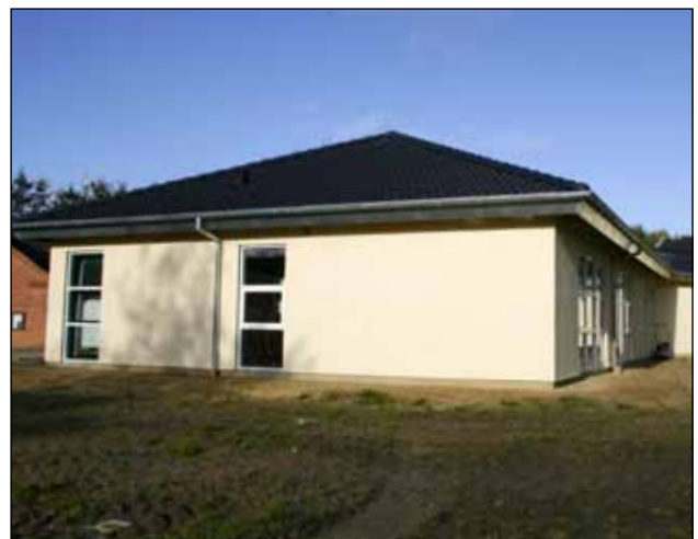
24. Facaden er færdigpudset.
