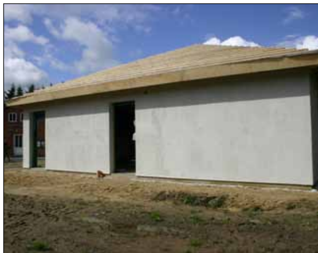
18. Hele facaden er behandlet med Grundpuds ilagt net.
