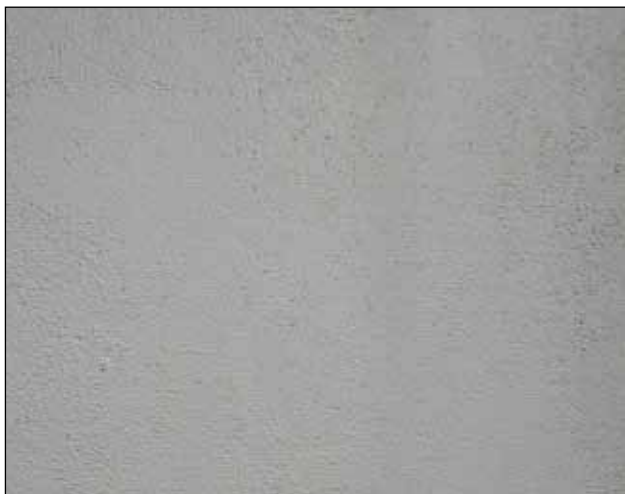
17. Man skal ganske svagt kunne fornemme nettets struktur. Det er vigtigt, at nettet ligger i den yderste tredjedel af pudslaget.
