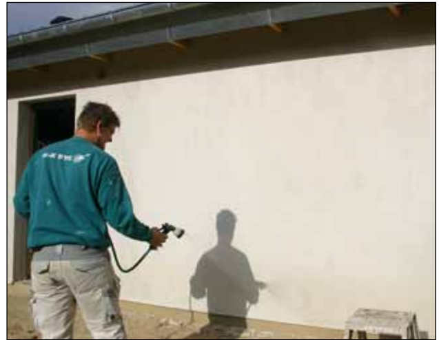
20. Efter ophærdning forvandes facaden.
