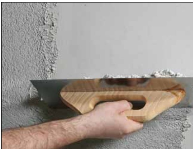
1. Skaltherm Grundpuds trækkes på i et jævnt lag på overfladen.
