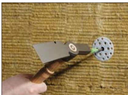
Isoleringspladerne limes op og fastgøres med 6-8 plastdybler per m 2 . Start fastgørelsen på sokkelkant eller sokkelprofil.
