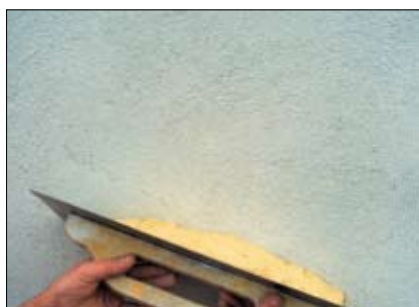
Efter 2 døgn optørring topbehandles med Skalcem S2000/CF2000 som trækkes på i en lagtykkelse på ca. 2 mm (husk at erstatte 2 liter af blandevandet med Beto-Binder). Efterfølgende flittses der med en tør mursvamp.
