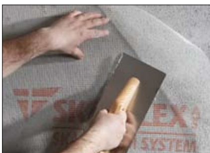
Der trykkes armeringsnet ind i den våde Grundpuds med stålbræt og glatpudses med plastpudsebræt.
