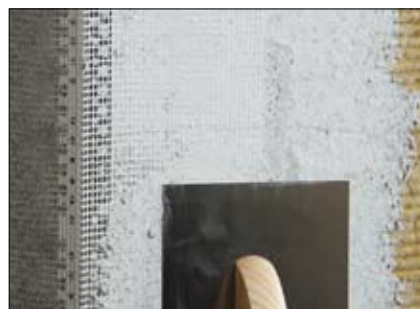
På hjørner og false monteres hjørneprofiler med net i Skaltherm Grundpuds. Derefter påføres Skaltherm Grundpuds med stålbræt, lagtykkelsen skal være 5-6 mm.
